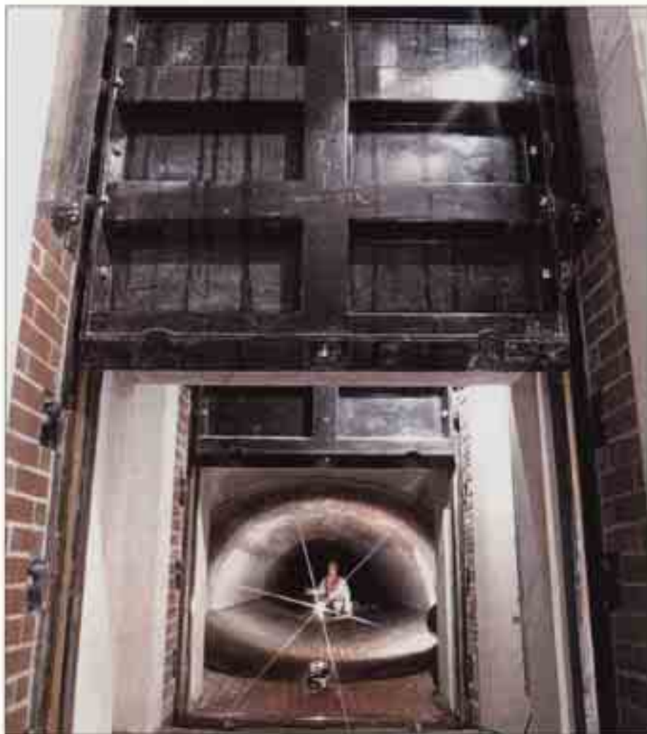
Absperrschieber aus GJL-250 für einen Abwasserkanal, Abmessungen: 1500 × 1500 mm
