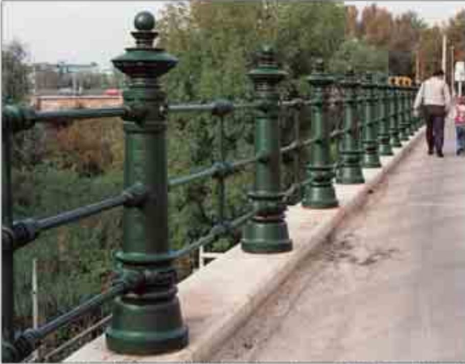
Brückengeländer mit Säulen und Verbindungselementen aus GJL-250, sog. Kaiser-Wilhelm-Balustrade
