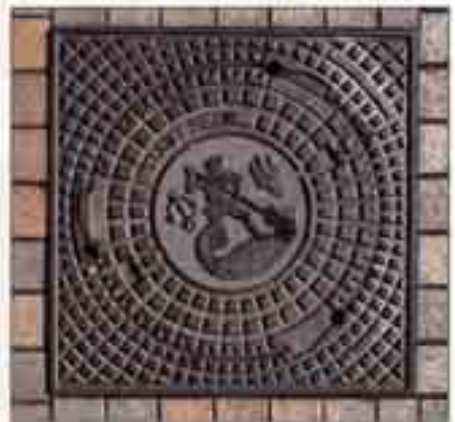
Aus Rahmen und Deckel bestehende Schachtabdeckung mit eingegossenem Wappen der Stadt Heide, Werkstoff: GJL-200
