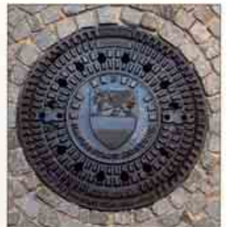
Straßenschachtabdeckung aus GJL-250 mit eingegossenem Stadtwappen von Rostock
