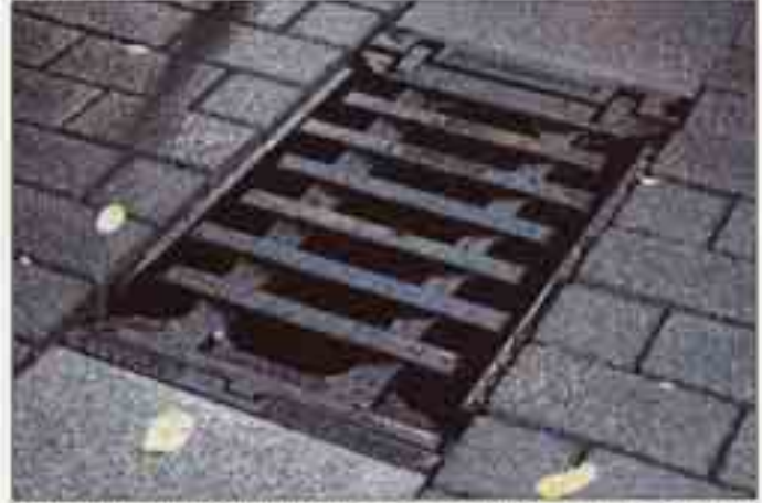
Je nach Einbaustelle werden Straßenabläufe aus GJL-250 oder -300 in den unterschiedlichsten Konstruktionen mit Belastungen von 15 bis 900 kN hergestellt
